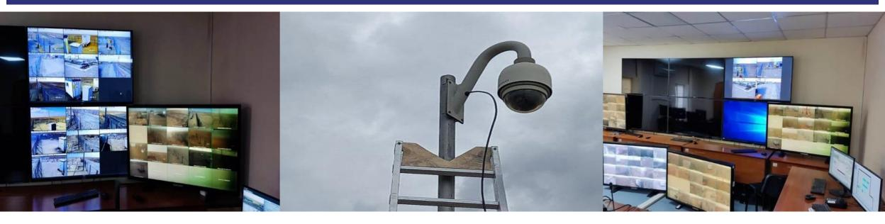
В ходе модернизации системы видеонаблюдения магистрального нефтепровода Кенкияк - Кумколь выполнены работы по замене внутриплощадочных кабелей на всех ЛКУ. Проведена замена аналоговых видеокамер Geutebruck на цифровые видеокамеры HikVision на 30 ЛКУ (линейный крановый узел) и 5 УППОУ (узел пуска приема станционных сооружений) и видеорегистраторы. Также заменены коммутаторы.
